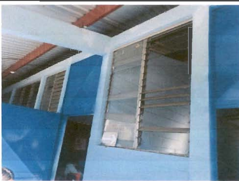
Foto 6: Sustitución de balcones de metal
