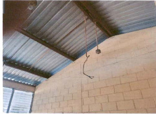
Foto 2: Reparación de sistema eléctrico
