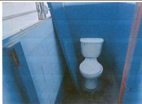
Foto 5: Cambio de inodoros
