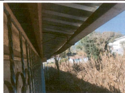
Foto 4: Cambio de canales y bajadas de agua pluvial
